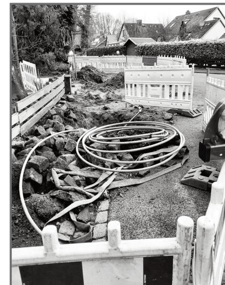
Rohrbruch mit Überbrückungsleitungen gegenüber der Abzweigung vom Alstergrund
